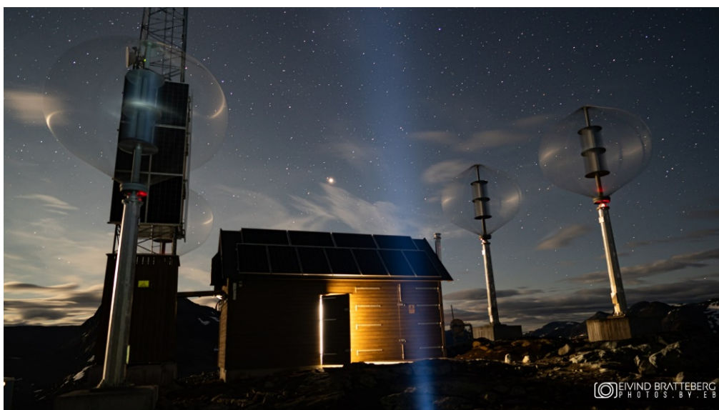
Figur 12.5 Telias basestasjonen ved Trollstigen har banebrytende, grønn teknologi. Foto: Eivind Bratteberg.
