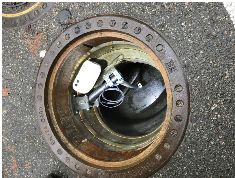
Figur 12.4 Sensorer montert i kum. Foto: Pipelife.
