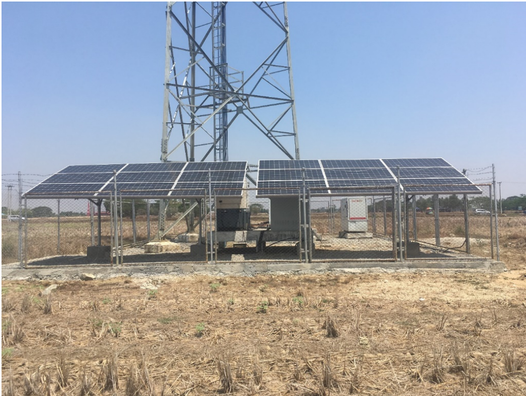
Figur 12.6 Solcellepanel på mobilstasjon i Myanmar. Foto: Telenor.
