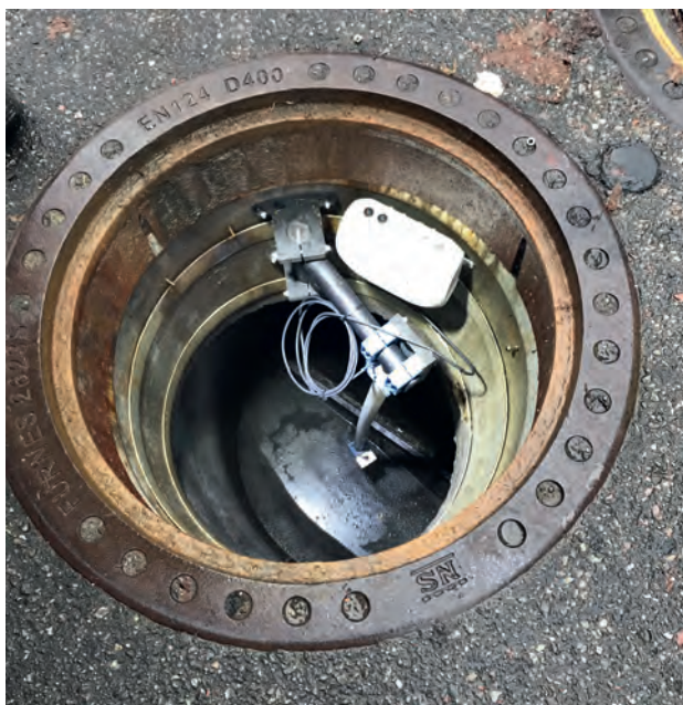
Figur 12.4 Sensorer montert i kum. Foto: Pipelife.
